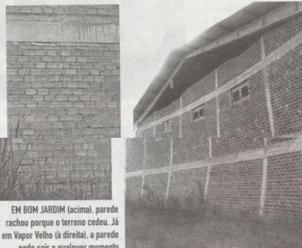
EM BOM JARDIM (acima), parede rachou porque o terreno cedeu. Já em Vapor Velho (à direita), a parede pode cair a qualquer momento
